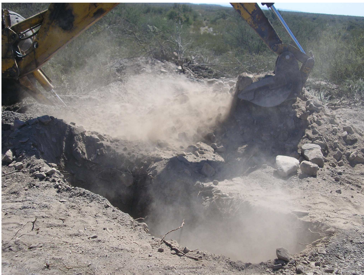
Foto que registra una imagen del trabajo realizado con máquina retroexcavadora.
